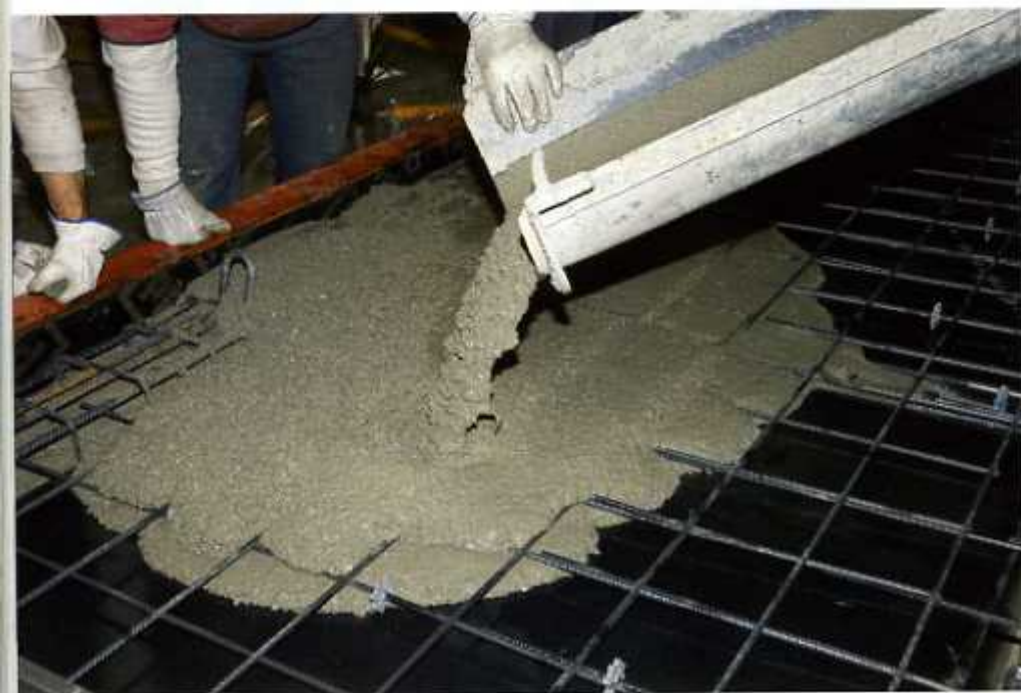
Construcción de la base de hormigón utilizando hormigón autocompactante
