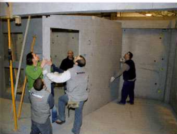
Instalación de los tabiques
