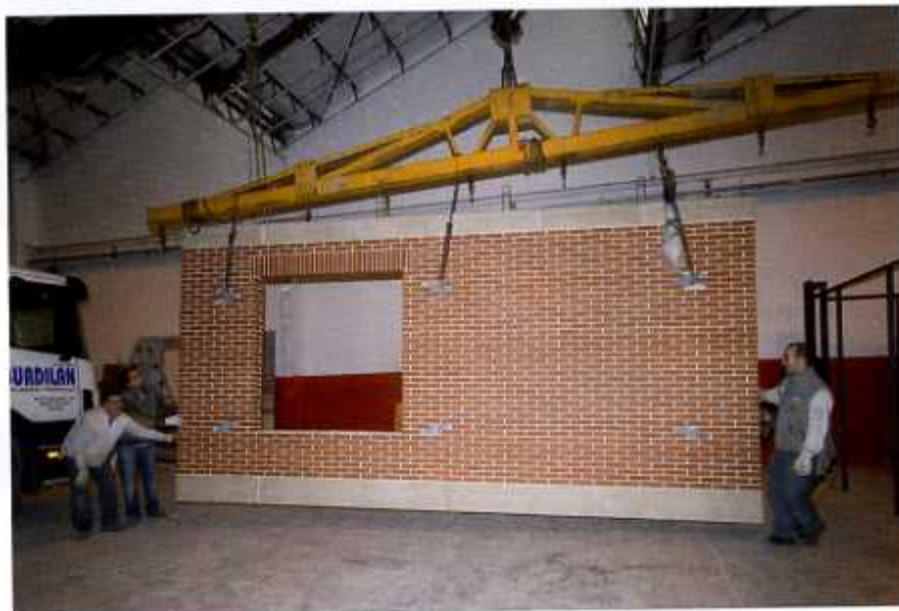
Instalación de las fachadas
