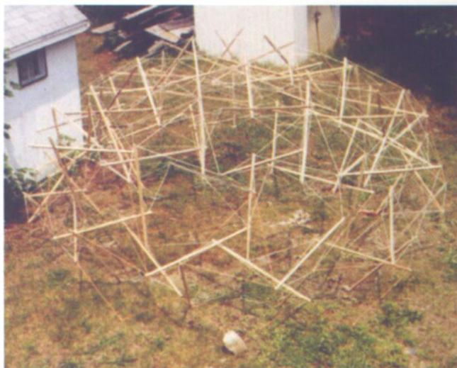
FIGURA 4. Cúpula tensegrítica 8v de doble capa realizada por Burkhardt.
