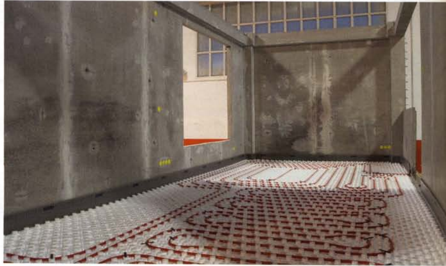
Modul mit integrierter Fußbodenheizung vor dem Glätten
