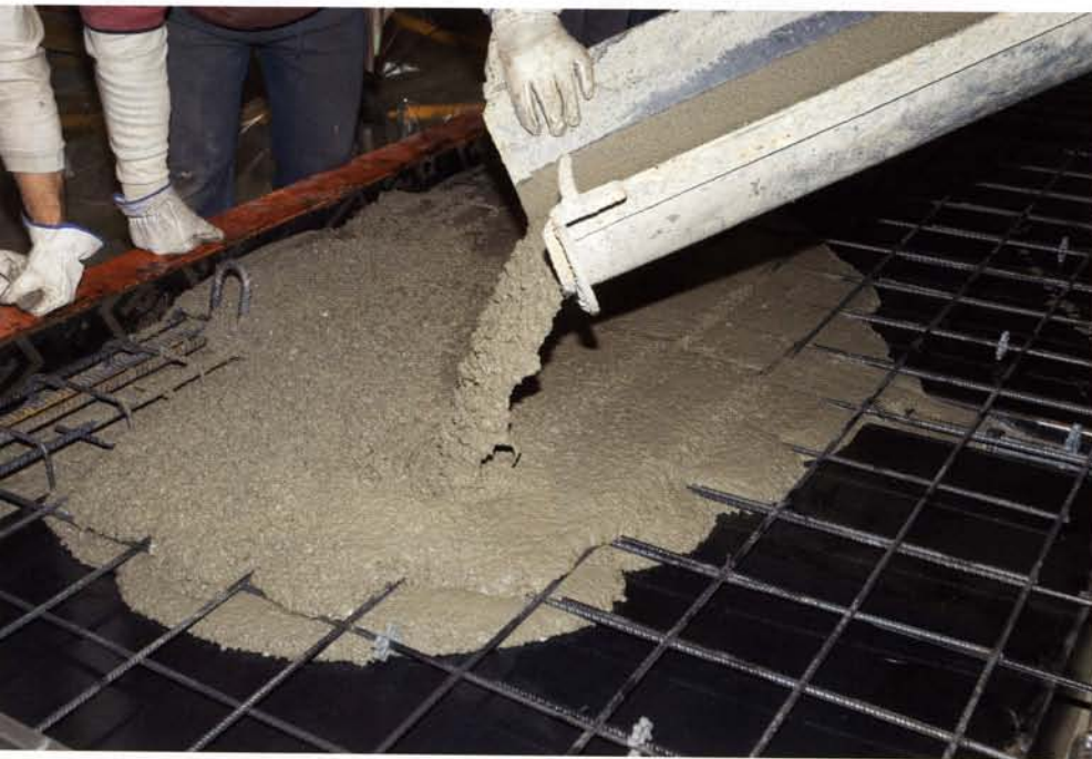
Errichtung des Betonfundamentes aus selbstverdichtendem Beton
