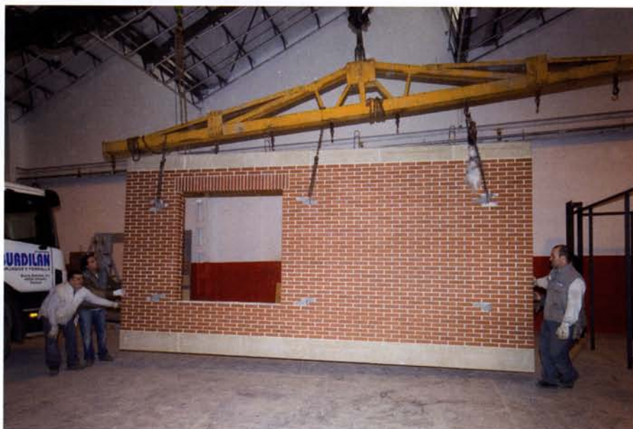
Einbau der Fassadenplatten
