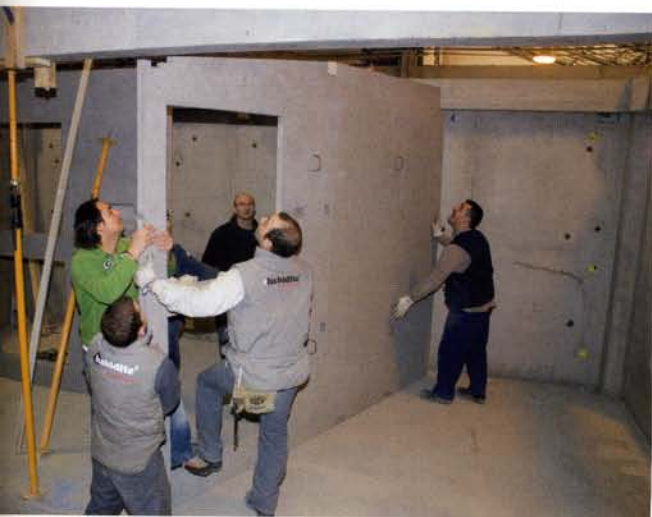
Einbau der Trennwände
